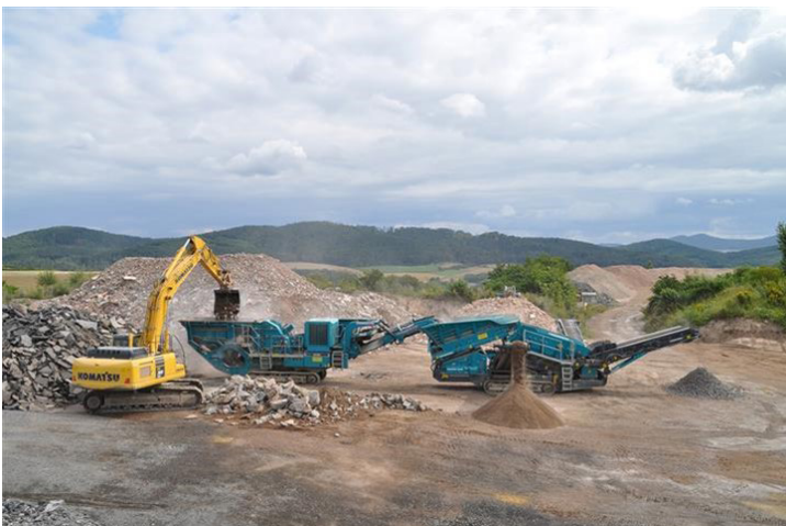
Die mineralischen Abbruchmaterialien wurden in einer mobilen Brechanlage in Volkmarsen recycelt. 61% der gewonnenen Sekundärrohstoffe fanden Verwendung im Neubau, davon 15% im Tragwerk. © ARGE agn heimspielarchitekten
