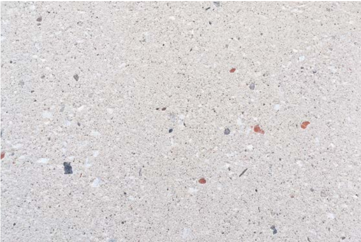
Fassade mit RC-Beton und Ziegelrezyklat © ARGE agn heimspielarchitekten
