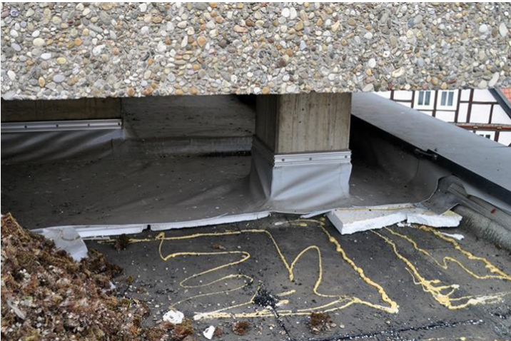
In Bestandsgebäuden sind in der Regel eine Vielzahl an Materialien verbaut, die von dem Beton oder Mauerwerk separiert werden müssen. © ARGE agn heimspielarchitekten
