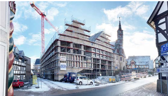
Baustellenbild - Kirchstrasse © ARGE agn heimspielarchitekten
